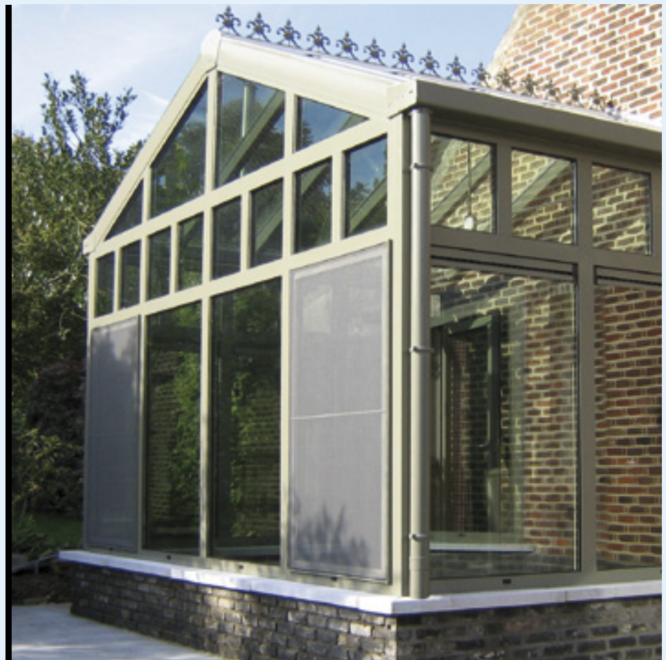
Climax® veranda - Overijse - B
